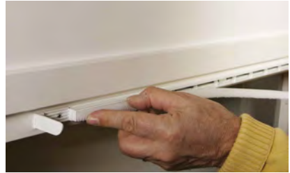
Elekrostaattisen allergeenisuodattimen vaihto
